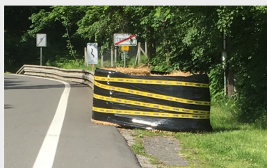
Utilisation adaptée de bottes de paille pour protéger un endroit dangereux
