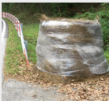
Extrémité de la glissière non protégée
