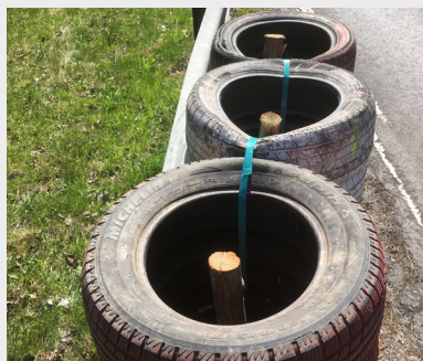
Pile de pneus bien conçue
